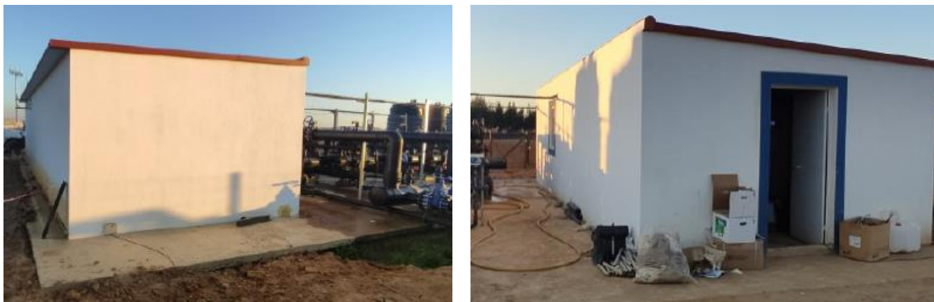
Figura 3.1 – Edifício de apoio da charca 1 , proteção do equipamento de controlo e monitorização do sistema de rega
