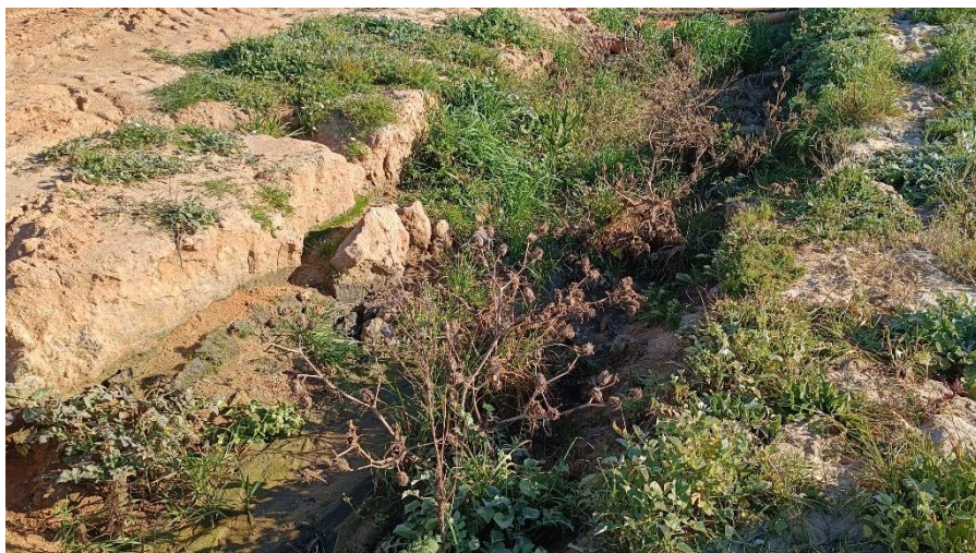
Figura 4.30 – Vala de drenagem com figueira-do-diabo
